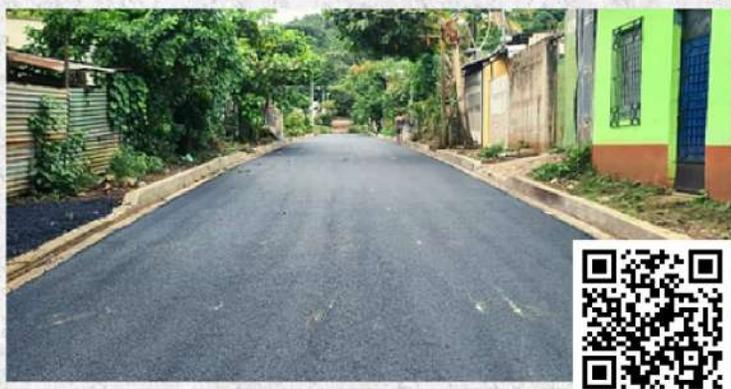
Este desarrollo vial consta de 192 metros lineales de capa asfáltica de 5cm de altura, sobre una base de lodocreto de 15 cm de altura y un sistema de cunetas laterales, asegurándonos de esta manera que le hemos entregado a la comunidad una obra de primera calidad.
